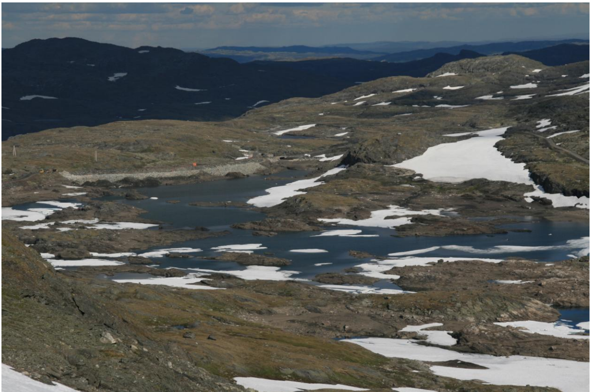
Store Vargevatet (1432 m.o.h.) den 23. juli 2017. Enno litt is. Anleggsarbeid på dammen.
